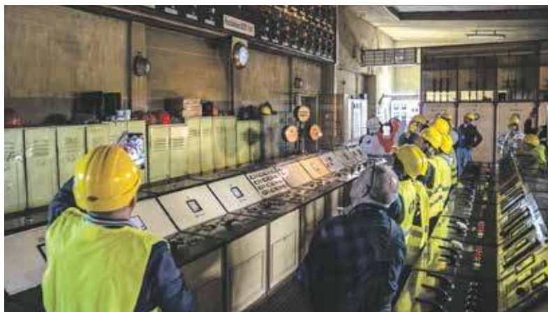
Podczas finału można wylicytować zwiedzanie na co dzień niedostępnych pomieszczeń Koksowni Bytom
