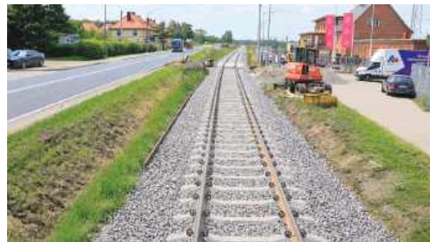
Trwa rewitalizacja linii kolejowej nr 319 na odcinku Strzelin – Kondratowice – Łagiewniki, która po 36 latach ma ponownie służyć pasażerom i przewoźnikom towarowym
