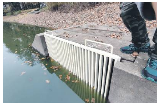
Wstawiona krata zapobiega ucieczce ryb do rowu poniżej i dalej do rzeki
