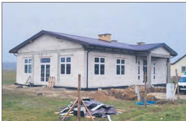
■ Budynek świetlicy w Sokoli już stoi. Teraz trwają prace nad jego wykończeniem (fot. Gmina Kłoczew)
