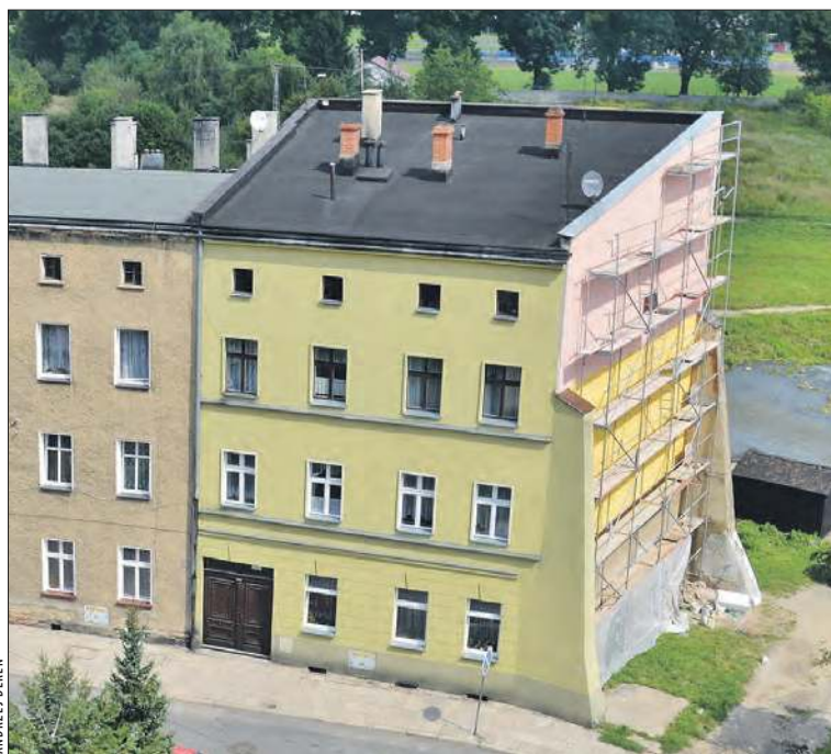
Jedną z kamienic, do której podłączona będzie instalacja c.o. będzie budynek przy ul. Chrobrego 16
