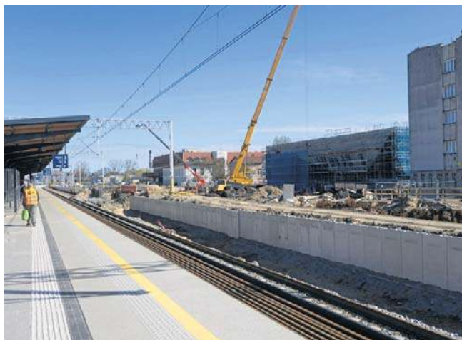
Roboty przy modernizacji stacji Słupsk
