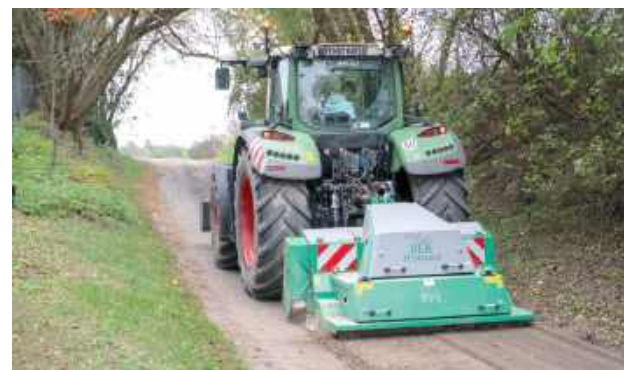
Recykler pracujący na drodze w Zakrzowie
