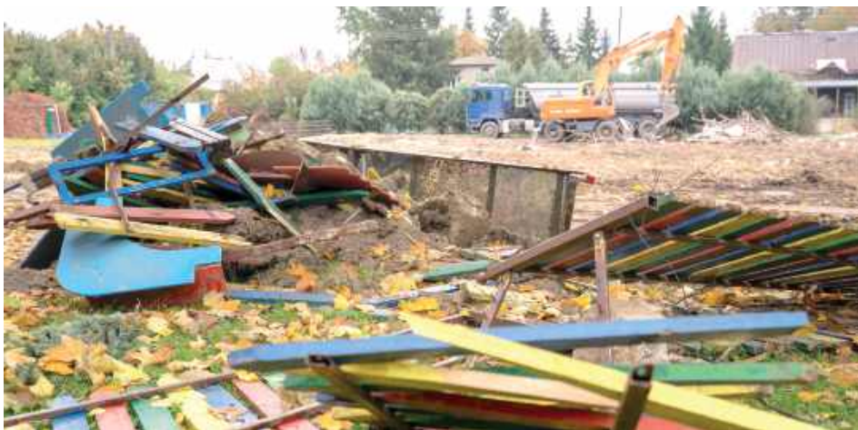
Rozbiórka przedszkola nr 1 w Łęcznej na finiszu
