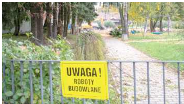
Rozbiórka przedszkola nr 1 w Łęcznej na finiszu
