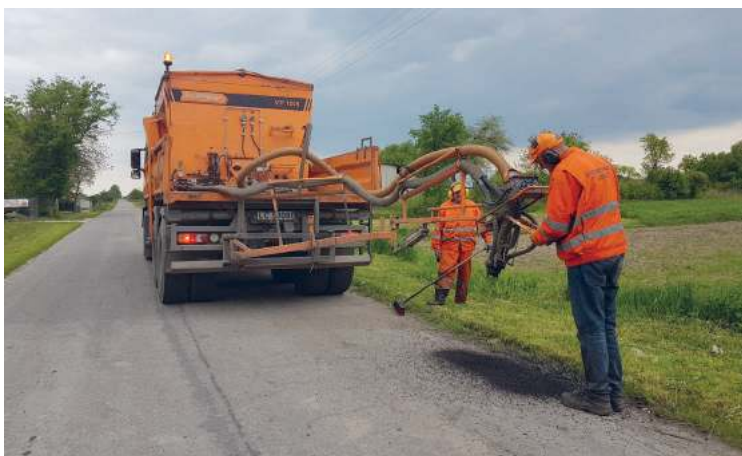
Pracownicy bazy z Sielca podczas remontu nawierzchni dróg powiatowych
