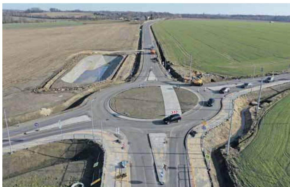
Przedłużają się prace przy przebudowie drogi krajowej
