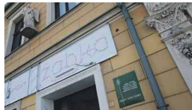
W ubiegłym tygodniu w miejscu szyldu po aptece zamontowano szyldek „Żabki”
