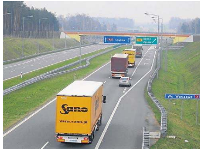
Autostrada A2 była budowana z założeniem, że jest za wąska. Teraz przyszedł czas na jej poszerzenie
