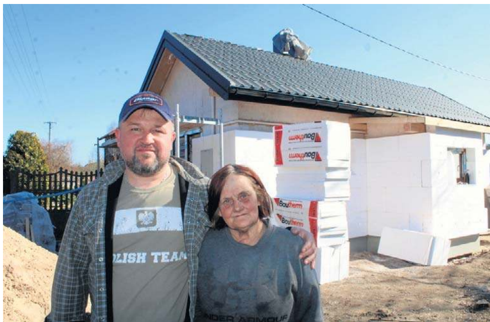
Ks. Mariusz Jędrzejczyk zmobilizował parafian do budowy małego domu dla pani Agnieszki. Dają pieniądze, materiały budowlane, wracają z pracy i przychodzą budować dom
