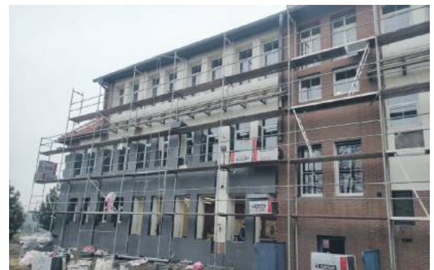
Prace przy termomodernizacji placówki w Kuropatniku są mocno zaawansowane. Fot. UMiG Strzelin
