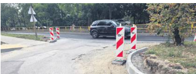
Prace potrwać do grudnia. Fot. UM Zamość
