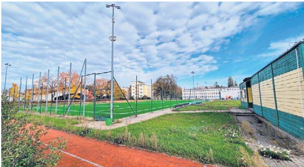
Miasto prowadzi równolegle inwestycje związane z budową nowych boisk i kompleksów oraz modernizację istniejącej infrastruktury
