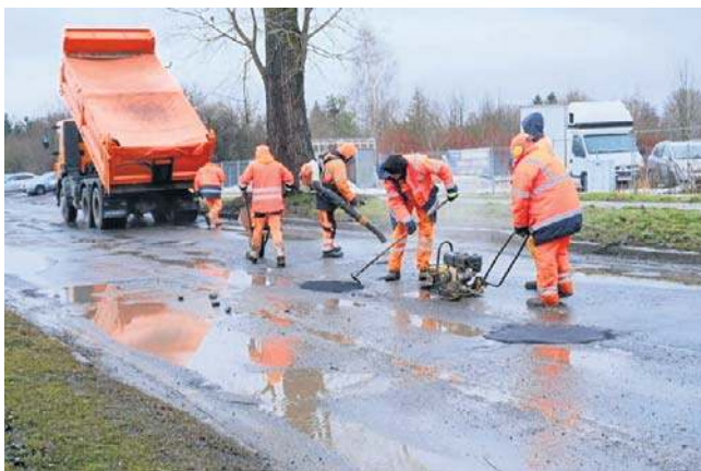
Drogowcy zalewają ubytki betonem asfaltowym na gorąco
