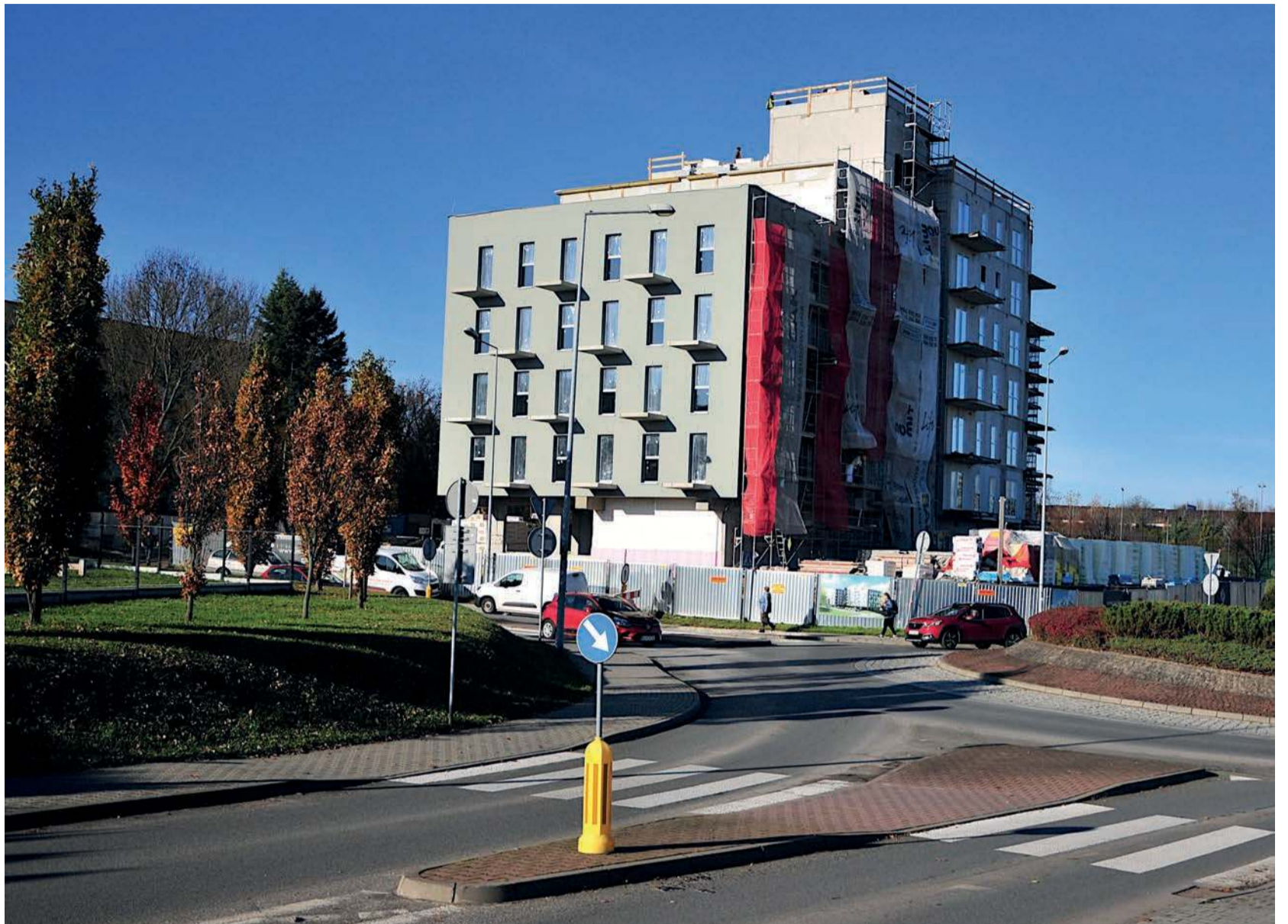
Budowa bloku mieszkalnego SIM na osiedlu Północ w Chrzanowie
