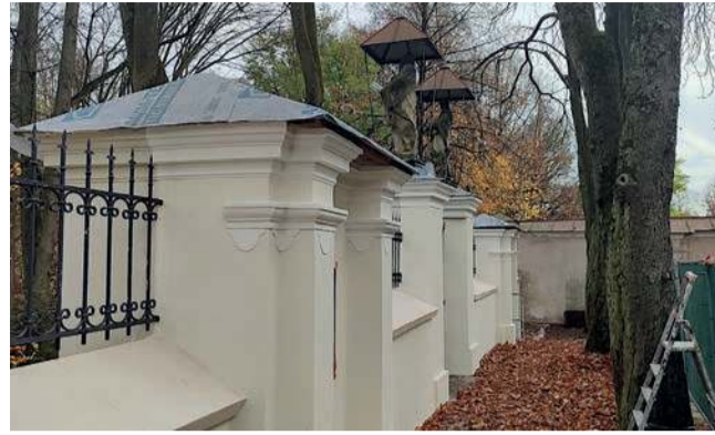
Remont fragmentu muru otaczającego klasztor w Alwerni
