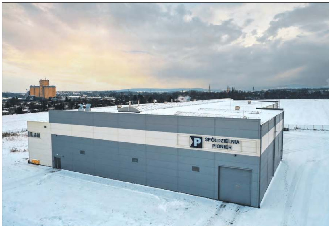
Nowa hala produkcyjno-magazynowa Pioniera przy ul. Przemysłowej w Prudniku
