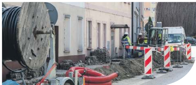
Prace ziemne przy ul. Głowackiego i Wąskiej dobiegają końca.
