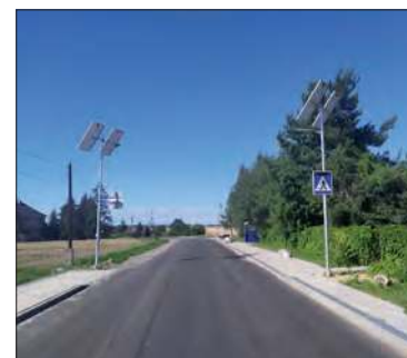
Przy przejściach dla pieszych zastosowano m.in. lampy zasilane energią słoneczną
