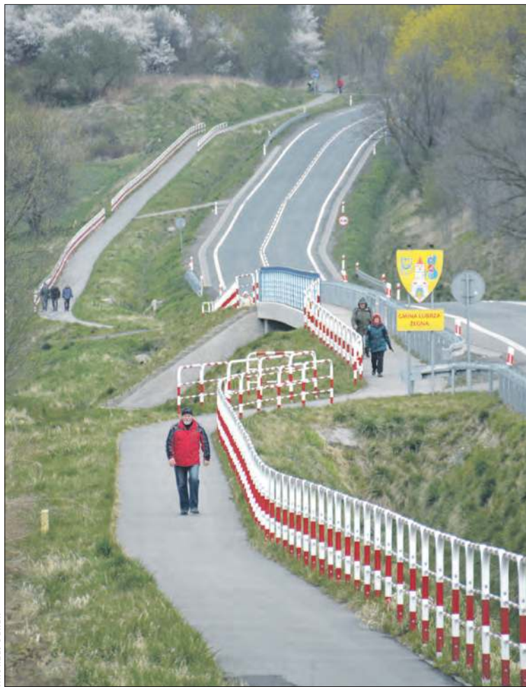
Obwodnica będzie stanowiła ciąg drogi krajowej z Trzebiny
