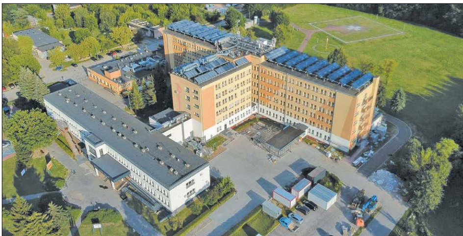
Co dalej z pediatrią w radzyńskim szpitalu? Powiat radzyński, pod który szpital podlega, zawiesił decyzję o jego wygaszeniu
