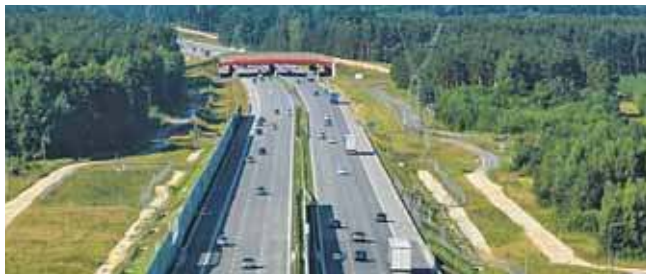
Budowa S11 została przyjęta do zadań realizowanych w ramach Rządowego Programu Budowy Dróg Krajowych do 2030 r. (z perspektywą do 2033 r.)
