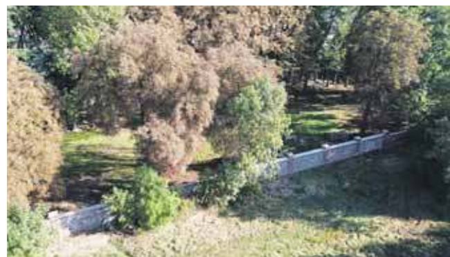
Ogrodzenie przy cmentarzu żydowskim zostało naprawione
