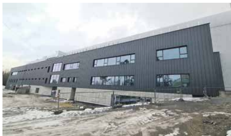
Najwyższej w Polsce położona hala z torami lodowymi miała być uruchomiona na przełomie października i listopada.
