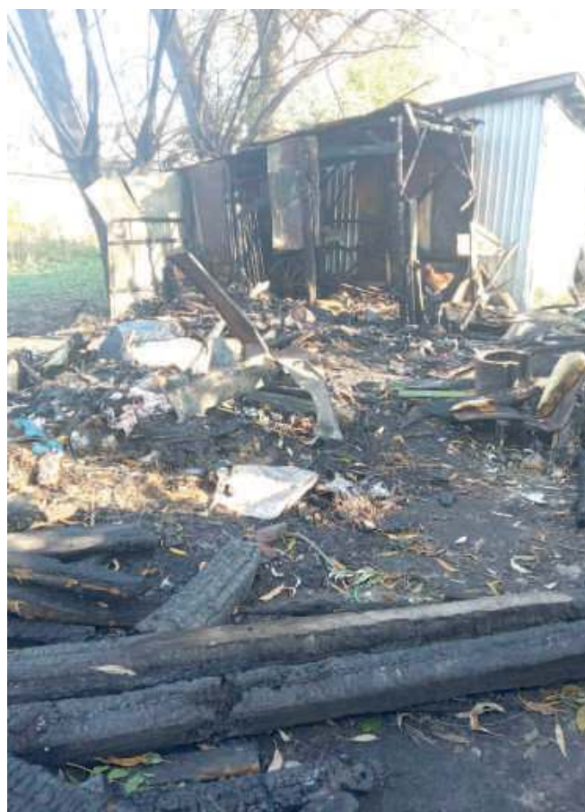
- Budynki gospodarcze nie były ubezpieczone. Rodzina potrzebuje ogromnej pomocy finansowej na odbudowę pomieszczeń gospodarczych oraz zakup opału na zimę - mówi Paweł Lasota, szef GOPS-u w Stoczku Łukowskim.
