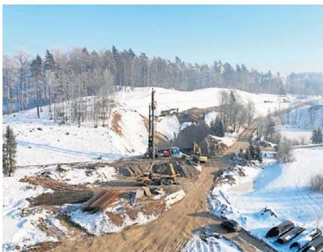
Sroga zima jest jednym z powodów opóźnienia prac przy budowie drugiego etapu obwodnicy Kartuz
