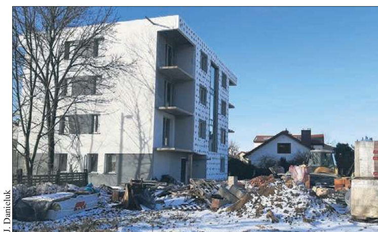
Prace przy budowie bloku przy ul. Polnej 7 są na półmetku
