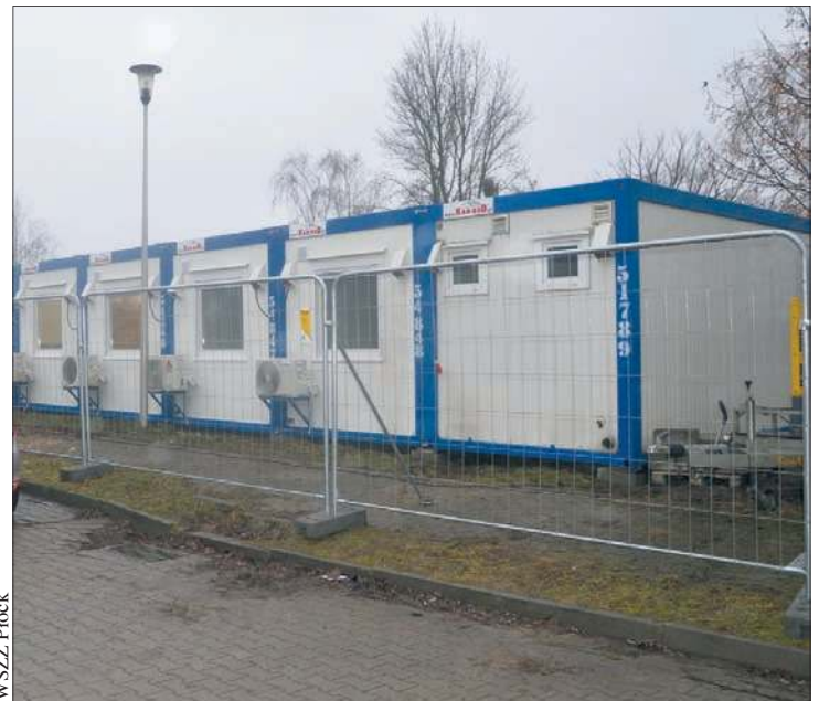
Budowa Ośrodka Radioterapii ma być ukończona we wrześniu 2023 r.
