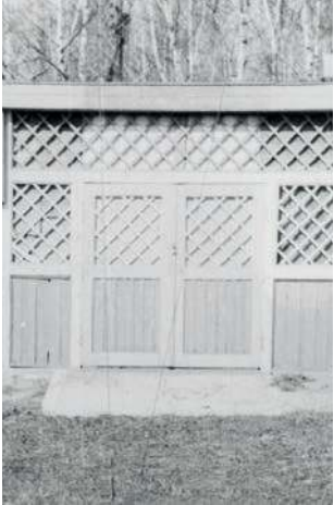
Przechowalnia kajaków dobudowana przez POSTiW do ściany budynku Ośrodka Wypoczynku Niedzielnego ZM Trzebinia, ok 1970 r.
