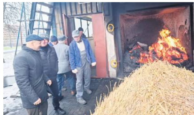
Podczas odbioru zadania wszyscy mieli możliwość zobaczyć, jak po modernizacji działa kotłownia.
