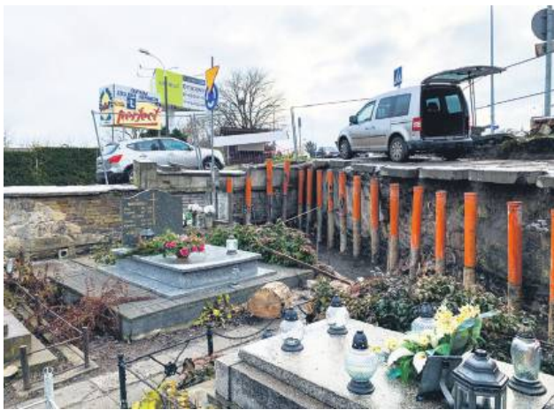
W pierwszym etapie remontu zaplanowano wykonanie zabezpieczenia uszkodzonego muru stalowymi mikropalami.
