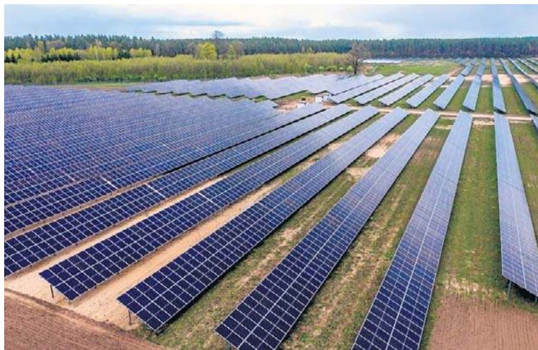
Na terenie Stacji Uzdatniania Wody „Zawada” powstanie farma fotowoltaiczna i największy w kraju (biorąc pod uwagę firmy wodociągowe) magazyn energii
