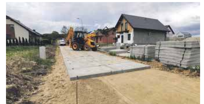
Do utwardzenia ulic wykorzystano płyty drogowe
