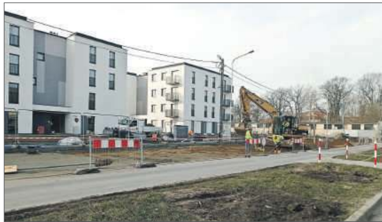
Parkingi i chodnik budowane są od strony tzw. mieszkań plus.
