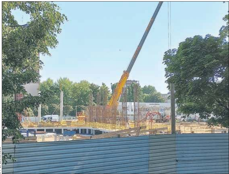
Za około dwa tygodnie pierwsze elementy konstrukcyjne aquaparku zaczną się wylaniać ponad ogrodzenie otaczające plac budowy
