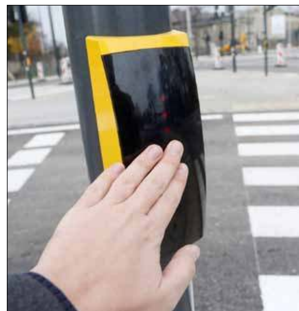
Przy przejściach dla pieszych zamontowano przyciski uruchamiające sygnalizację świetlną
