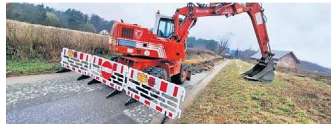
Utrudnienia są spowodowane rozpoczętą tu budową kanalizacji
