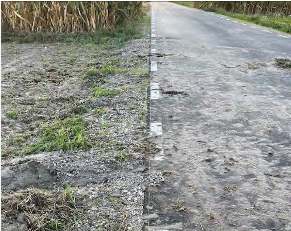
➤ Zryte sprzętem pobocze i liczne zabrudzenia na jezdni - tak wyglądała ul. Nowa w Kłoczewie po pracach polowych jednego z miejscowych rolników (fot. Urząd Gminy Kłoczew)
