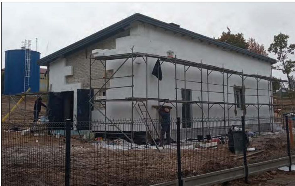
➤ Obecnie trwają prace nad ociepleniem i elewacją budynku stacji w Nowodworze. Obiekt ma być gotowy do końca roku
