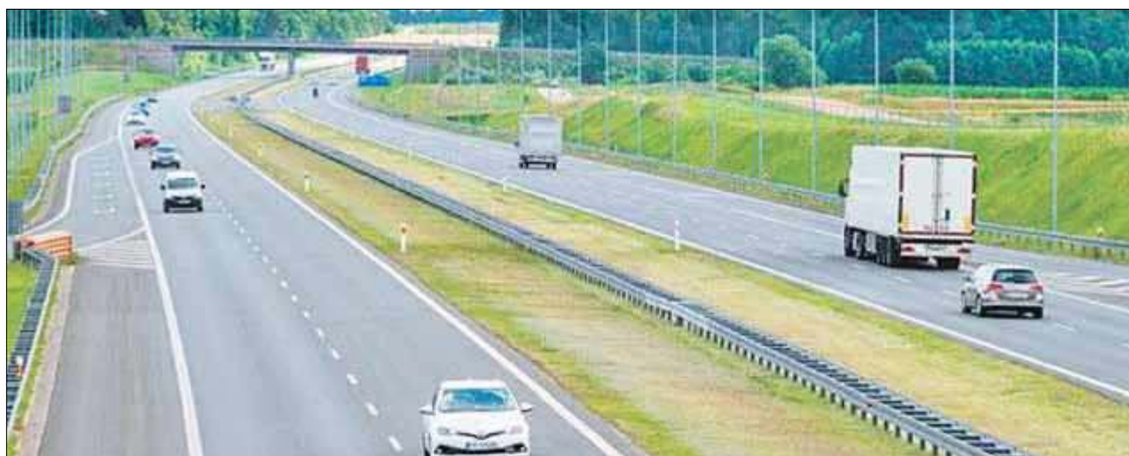
Na odcinku Swory – węzeł Cicibór (węzeł Biała Podlaska) rozpoczęcie robót budowlanych planowane jest na drugi kwartał 2022 roku. Inwestycja planowo ma zakończyć się w drugim półroczu 2024 roku
