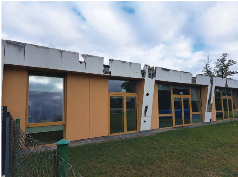
Jeszcze przed zimą na budynku przedszkola w Przemiarowie ma być wykonany dach. Całkowita odbudowa w przyszłym roku
