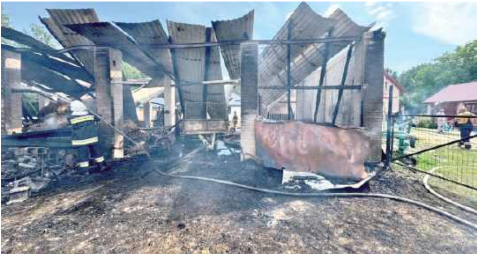
Zdjęcia ze strony zbiórki ukazują skalę zniszczeń...
