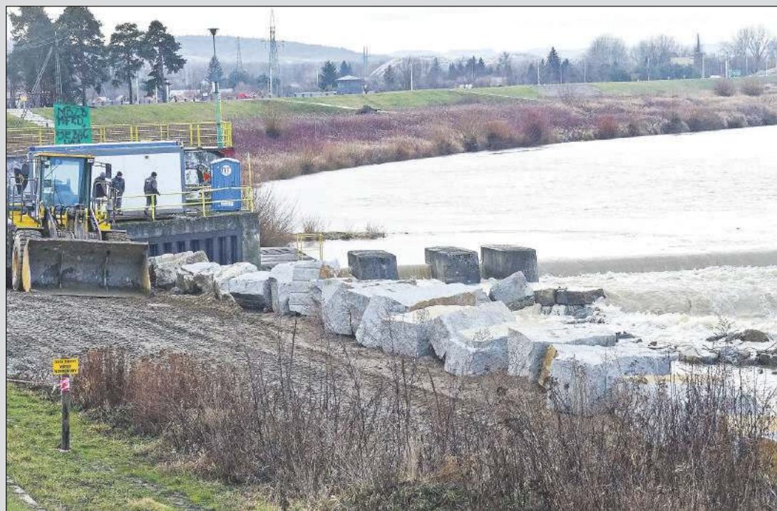
Trwa przebudowa tamy na Wisłoce. Teren sąsiadujący z al. Jana Pawła II w Dębicy jest ogrodzony, a na miejscu pracuje ciężki sprzęt. Przebudowa przepławki dla ryb i budowa kamiennej rampy kosztować ma ponad 1,6 mln zł. Prace, które zakończyć się mają jesienią tego roku prowadzi Państwowe Gospodarstwo Wodne Wody Polskie w ramach projektu Wisłoka bez barier.
