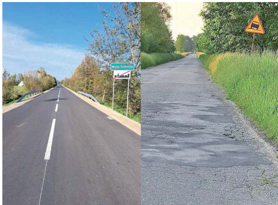
Droga była w fatalnym stanie, a jej przebudowa trwała niespełna trzy miesiące. To jedna z wielu dróg w gminie Siemień remontowana przy wsparciu środków unijnych, a remonty dotyczyły również dróg powiatowych w Siemieniu, Woli Tulnickiej, Tulnikach, Władysławowie i Wierchowinach Nowych
