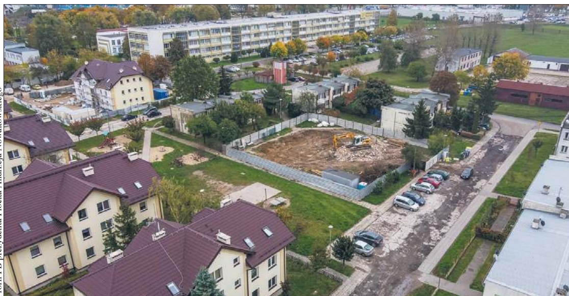
Na osiedlu Miodowa Jar dobiega końca dziewiąty blok mieszkalny, przygotowany jest też teren pod dziesiąty budynek
