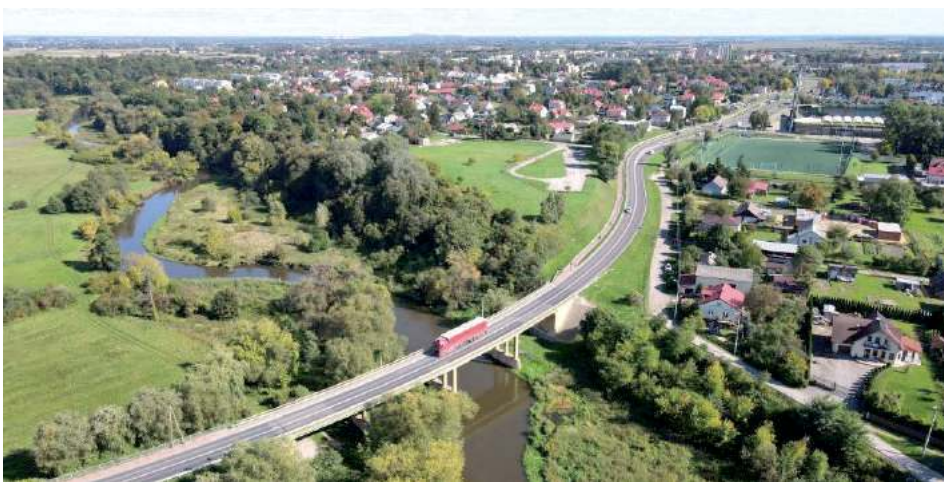
Stary most jest w złym stanie technicznym i czeka go rozbiórka
