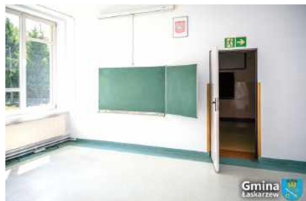
W ramach prac remontowane były m.in. podłogi, ściany, zamontowano nowe drzwi wewnętrzne
