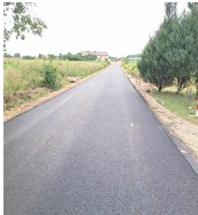
ok Gmina Żelechów remontuje kolejną drogę
