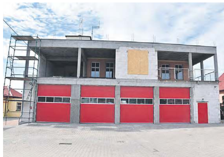
Jesienią ma być ogłoszony przetarg na dokończenie budowy.
