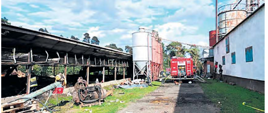
Jednym z zadań strażaków była obrona budynków i innych obiektów sąsiadujących z kurnikiem. Bezpośrednio zagrożone były np. silosy. Fot. KP PSP Tuchola
