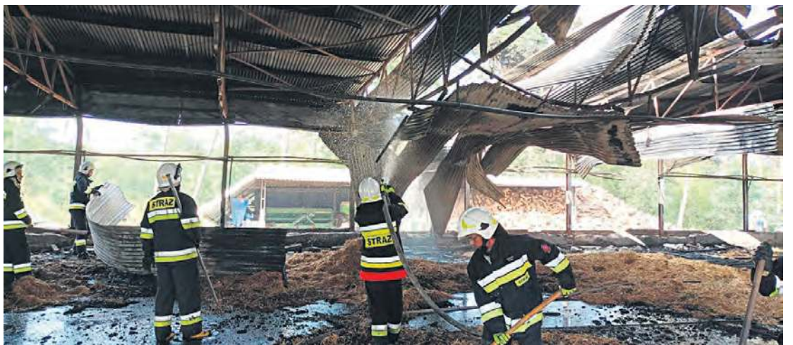
Dogaszanie i prace porządkowe. Do całej akcji ruszyły aż 22 zastępy straży pożarnej. Fot. KP PSP Tuchola
