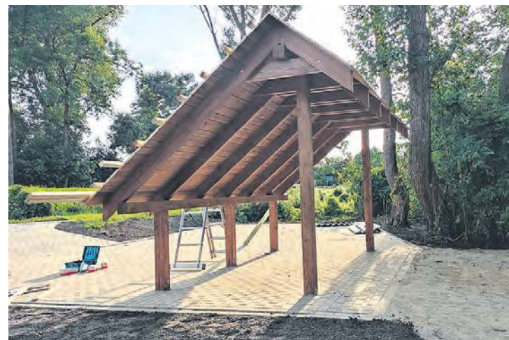
Wiata wypoczynkowa wkrótce będzie gotowa.
