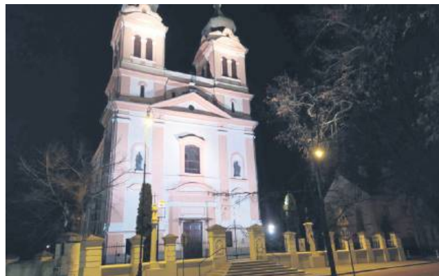
Wykonany będzie remont kościoła pw. Wniebowzięcia Najświętszej Marii Panny.
