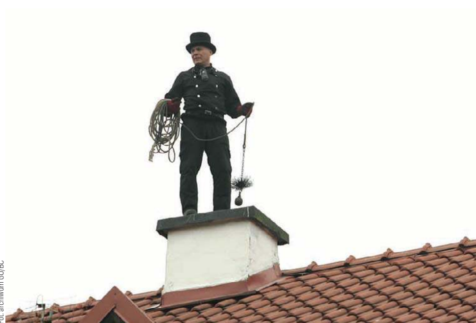
Przewody kominowe powinny być sprawdzane przynajmniej raz w roku
