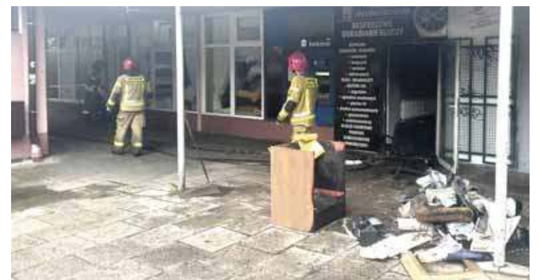
Po ugaszeniu ognia, strażacy oddymili pomieszczenie oraz usunęli zniszczone sprzęty
