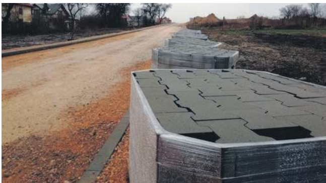
Kostka przygotowana do brukowania Leszczynowej w Chrzanowie
