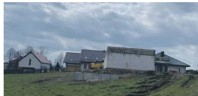
Koronawirus nie zatrzymał budowy nowych domów
