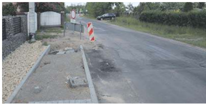
Myszków, ulica Szpitalna tuż za obwodnicą. Brakujące 100 metrów będzie uzupełnione po przełożeniu gazociągu.
