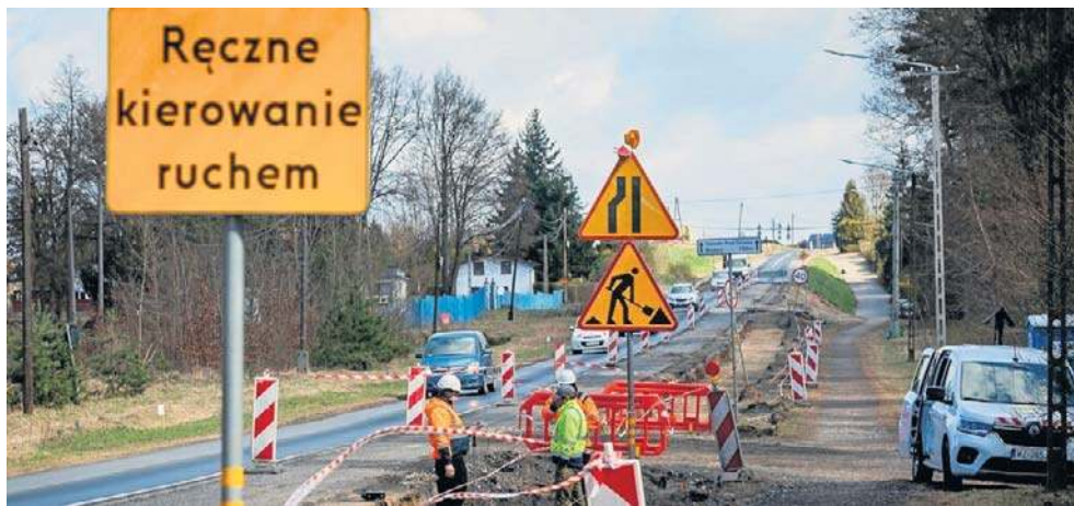
W Żołędowie trwa modernizacja drogi wojewódzkiej nr 244
