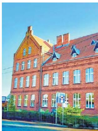
Prace prowadzone będą m. in. SP nr 1 imienia Wojska Polskiego
