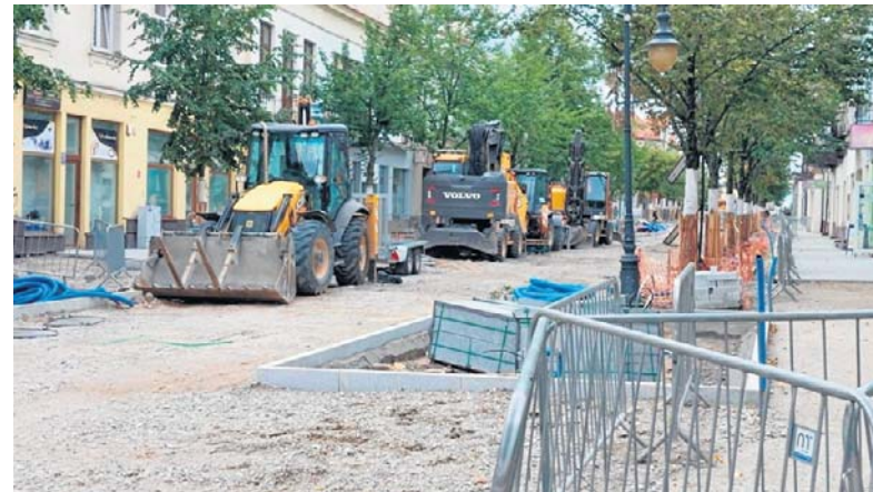
Roboty związane z powstaniem nowoczesnego woonerfu na ulicy 3 Maja trwają już wiele miesięcy
