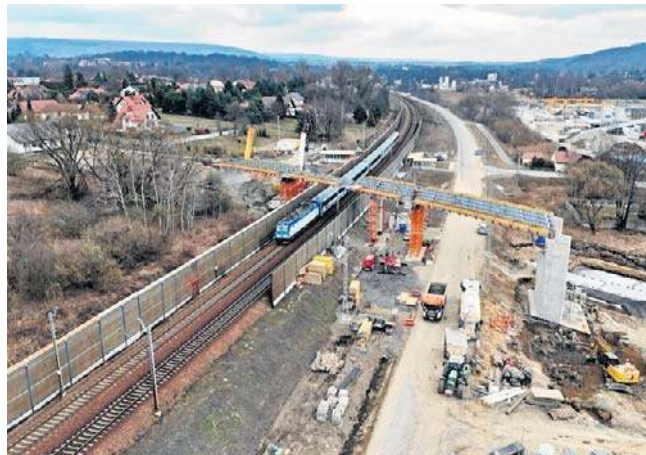
Prace przy budowie wiaduktu w Woli Filipowskiej idą pełną parą i wyraźnie widać postępy
