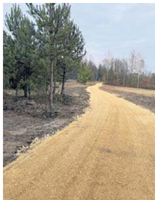
W Bukownie powstają nowe ścieżki rowerowe
